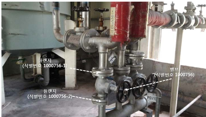
< 그림 4-224 > 수직배관에서의 플랜지 일련번호 부여 예시
