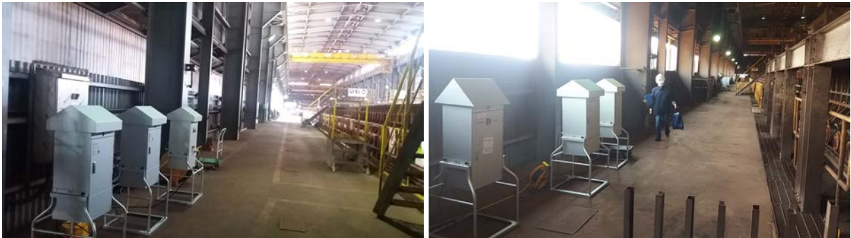
< 그림 4-130 > 소결로 측면 비산먼지 측정 예시
