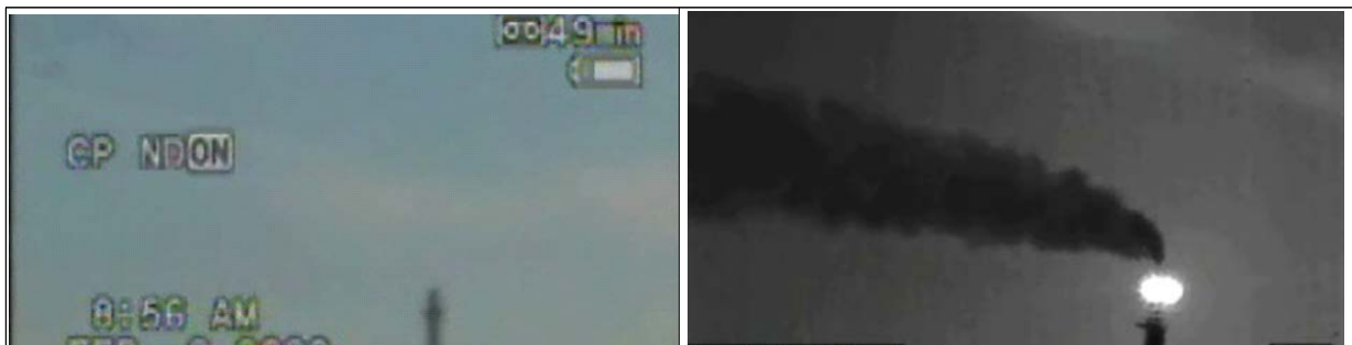
< 그림 4-151 > 플레어스택 불완전연소 모니터링 예시
