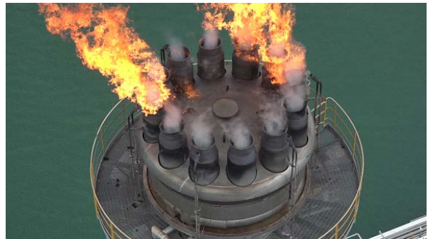
[ 스팀 과량투입에 따른 배출가스 불완전연소 사례 ]
