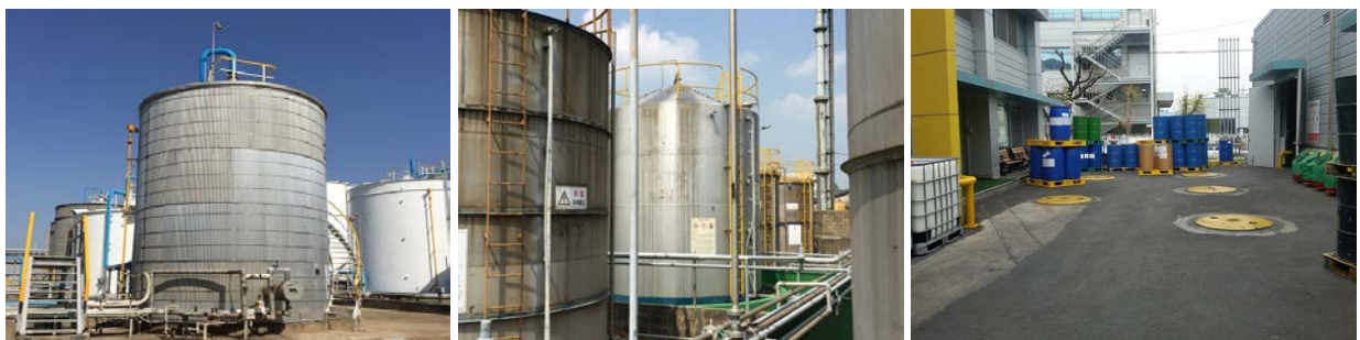
[고정지붕형 저장시설 예시(CRT, Cone Roof Tank)]
