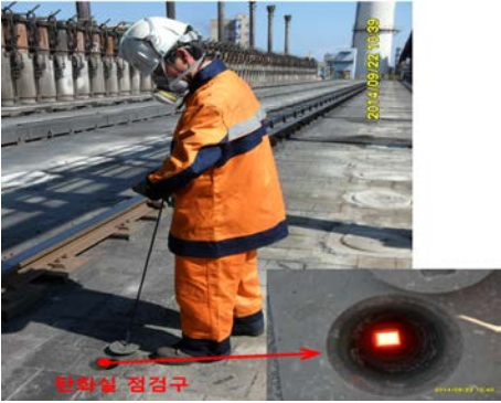
< 그림 4-163 > 코크스 탄화실과 연소실 격벽의 누출상태 점검 예시
