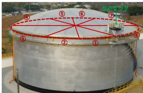
< 그림 2-17 > I·Ⅲ업종 돛지붕형 저장시설의 밀폐장치 파악 예시
