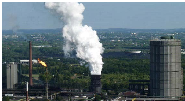
< 그림 1-34 > 코크스로 습식냉각타워 예시
