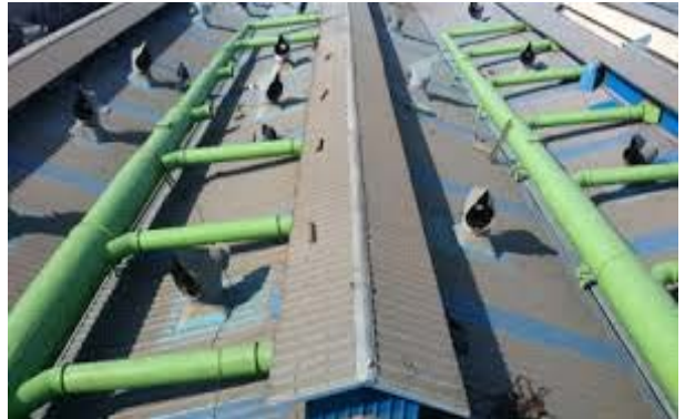
[ 고정식 벽체로 설치된 작업공간(건육집진시설) ]
