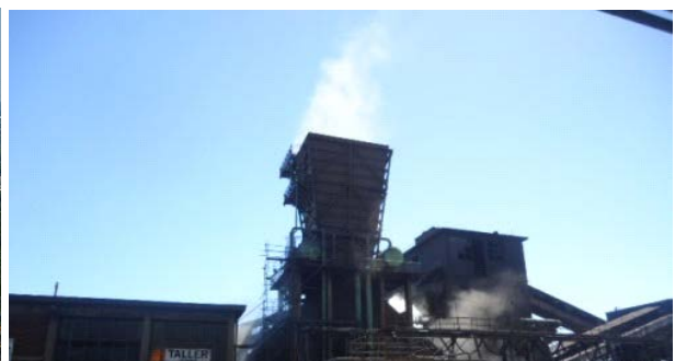
< 그림 1-34 > 코크스로 습식냉각타워 예시
