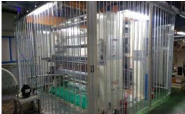
[ 유동식 벽체(접이식 플라스틱)로 설치된 작업공간 ]
